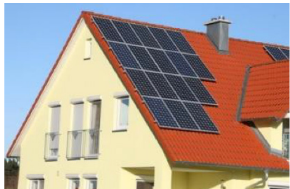
Figura 2. Casa con paneles solares.
