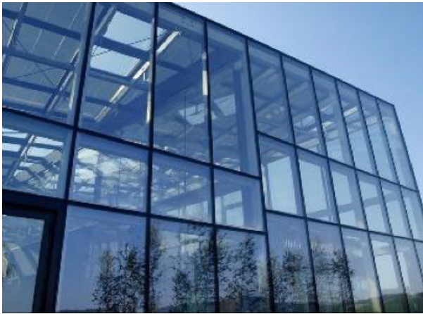
Figura 3. Edificio construido con vidrios fotovoltaicos.
